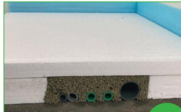
Darüber liegende Dämmschicht
