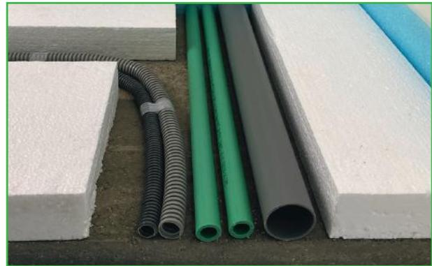
Installationsebene mit Dämmplatten des Anwendungstyps DEO
