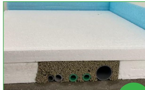
Darüber liegende Dämmschicht
