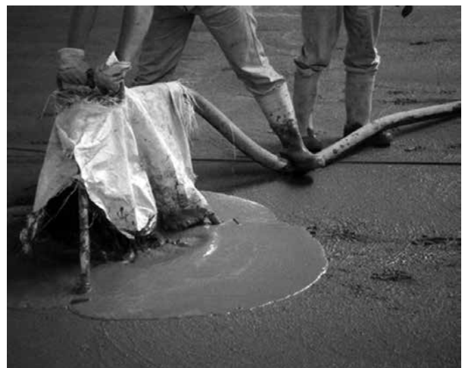
Bild 8: Ausbringen des Hartstoffestrichs frisch in frisch
