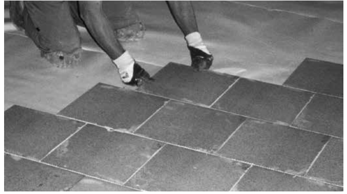
Bild 9: Fertigteilestrich aus zementgebundenen Platten
