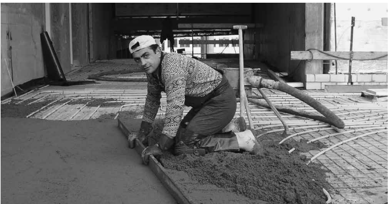
Bild 1: Estricheinbau
