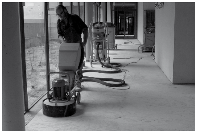
Bild 10: Anschleifen eines Zementestrichs
