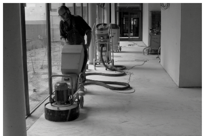
Bild 10: Anschleifen eines Zementestrichs
