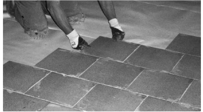
Bild 9: Fertigteilestrich aus zementgebundenen Platten
