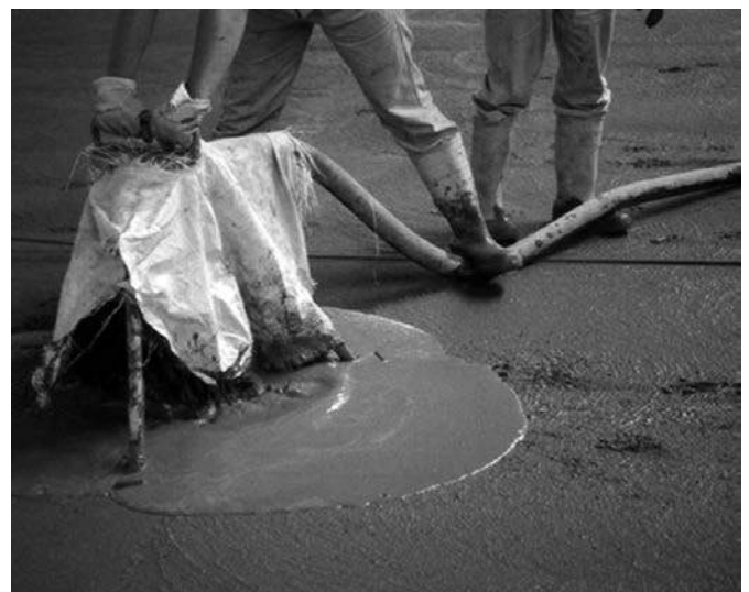
Bild 8: Ausbringen des Hartstoffestrichs frisch in frisch
