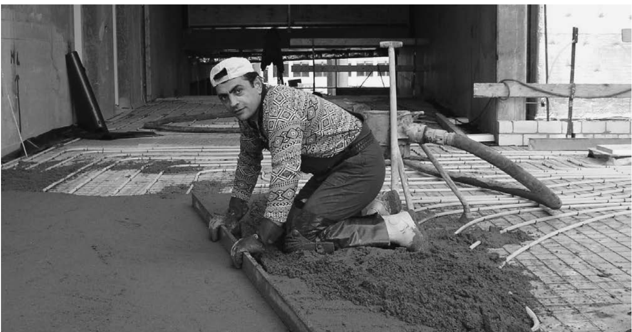
Bild 1: Estricheinbau
